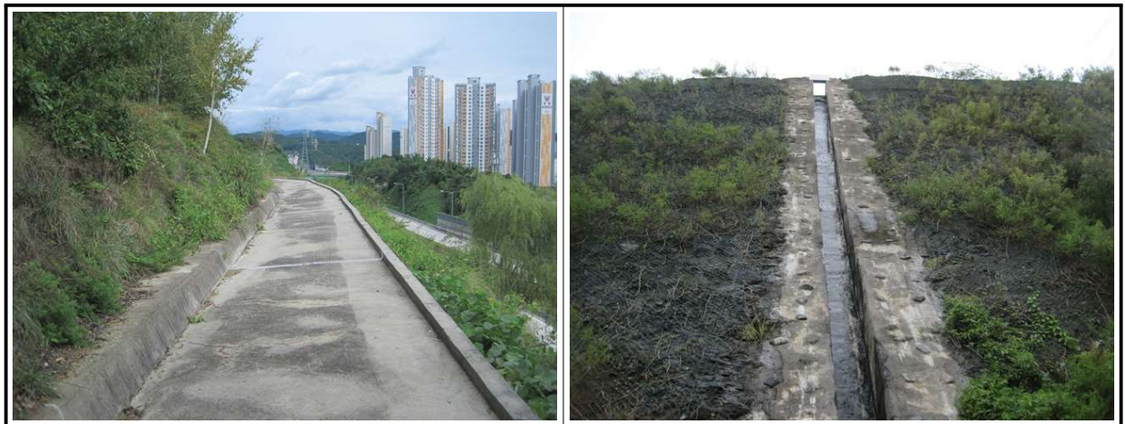
【그림 8.3.3】 배수시설 전경
